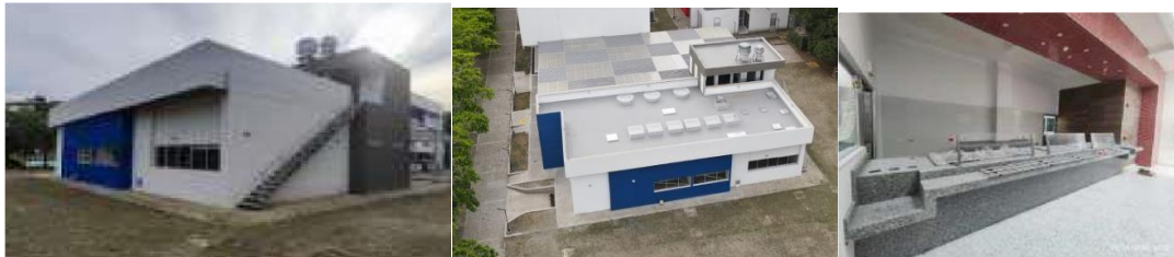
EDIFICIO COD No.220 “EDIFICIO CENTRO DE PRODUCCION DE ALIMENTOS”
