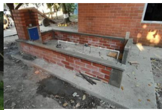
POZO AREA DE MANTENIMIENTO Y LOGISTICA
