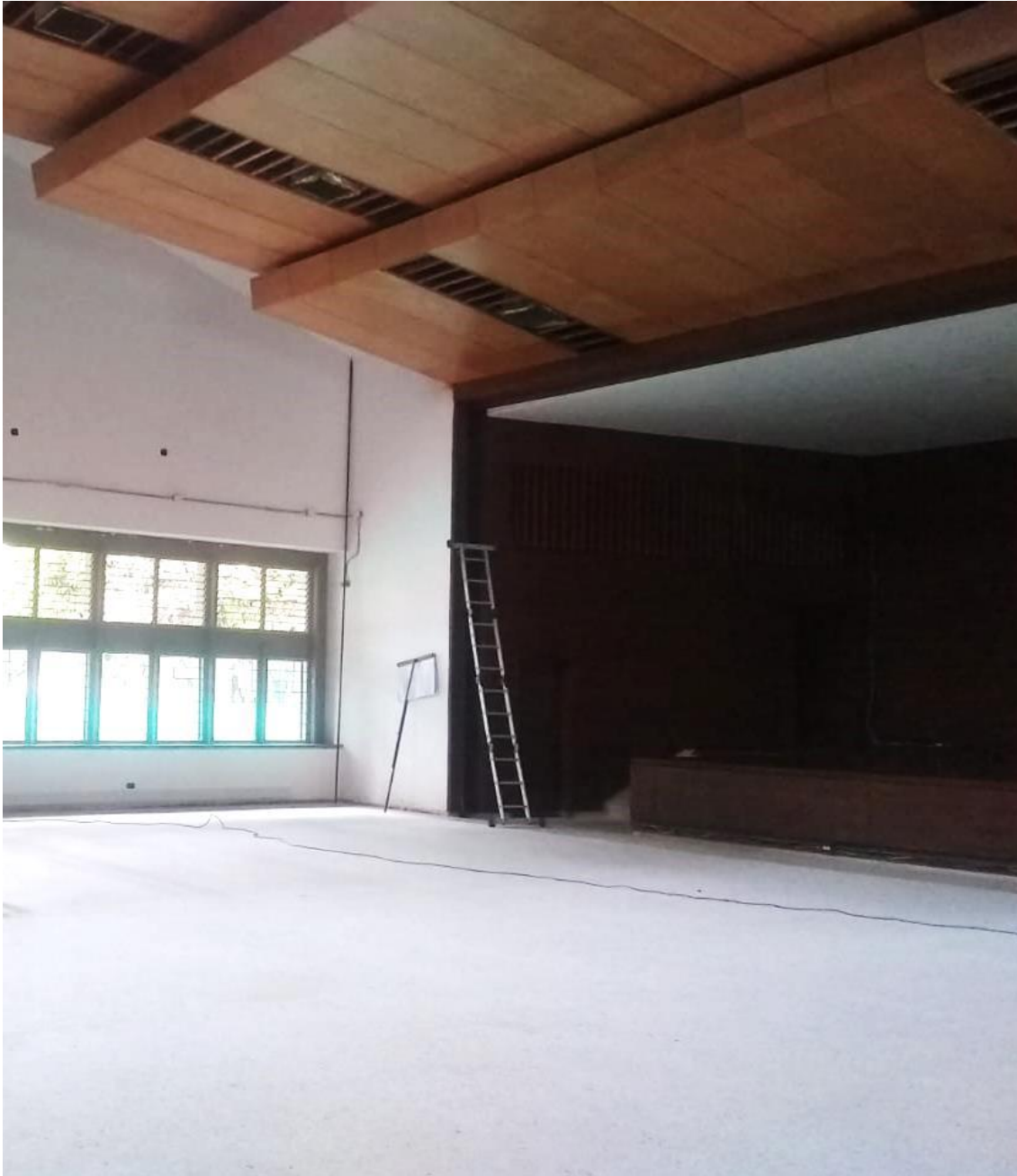
Mejoramiento del enchape de madera del cielo y renovación de piso.
