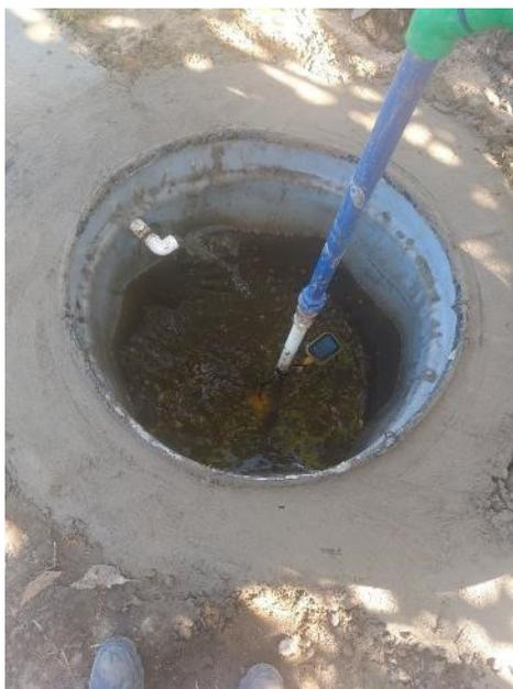
*Figura 3. Tanque de almacenamiento del vertimiento con carbón tipo antracita*
